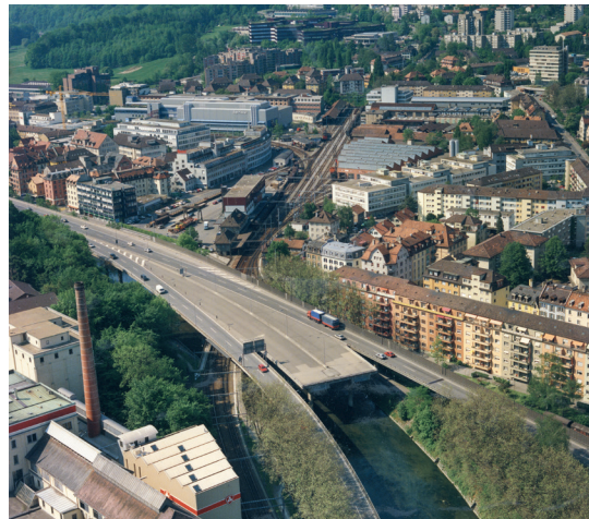
Luftbild der Sihlhochstrasse beim Bahnhof Giesshübel aus dem Jahr 1990.
